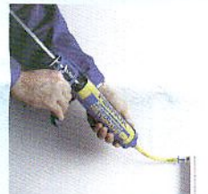
Zugabe über das Entlüftungsventil eines Heizkörpers (ein geeignetes Anschluss-Set ist mitgeliefert)
